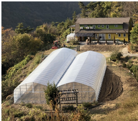
完成したビニールハウス
